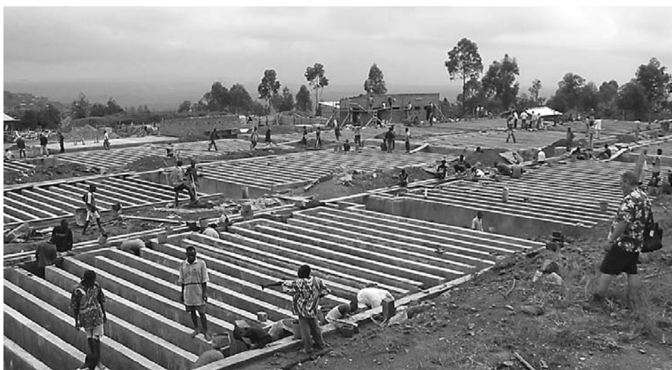
Usine de Kalongo en chantier
